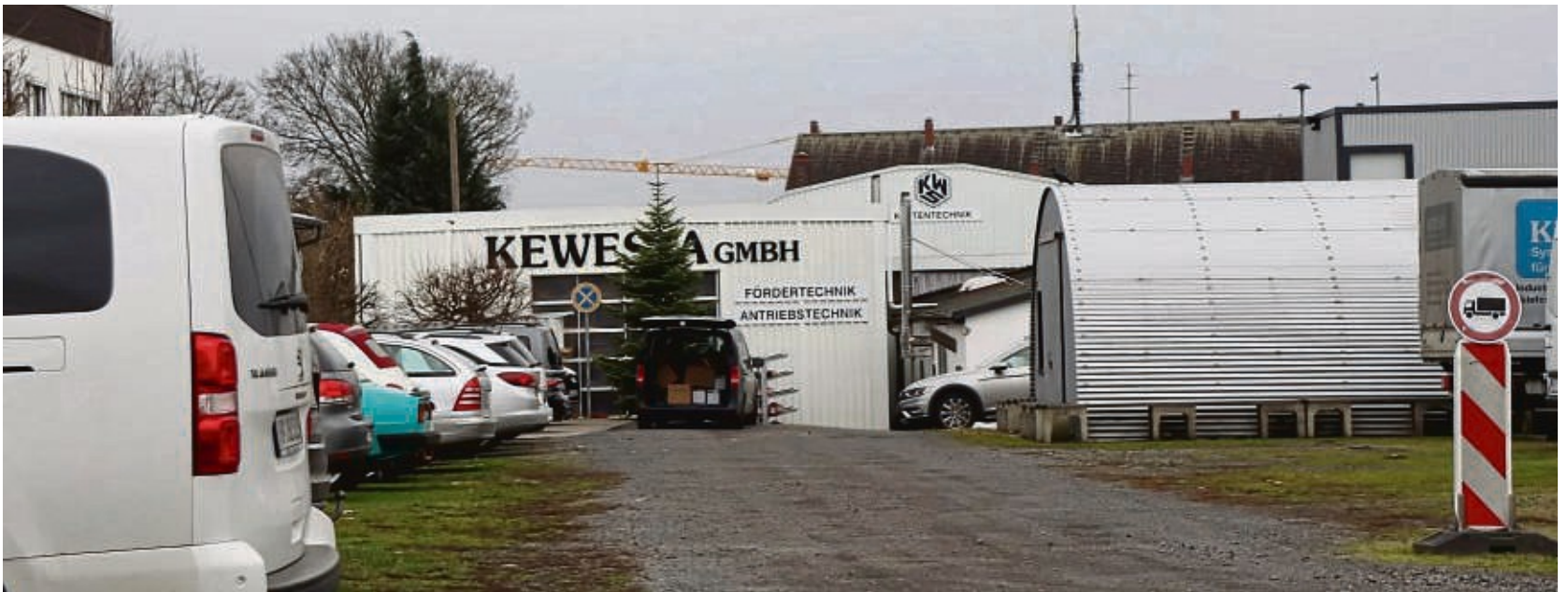
Auf dem Firmengelände der Kewesta GmbH an der Weingartenstraße werden Spezialketten und Förderanlagen produziert.
